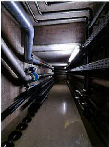
Canaux techniques entre les ouvrages
